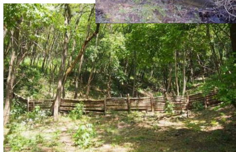
Nieszczelna tama w Püspökszilágy, Węgry
