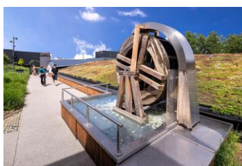
Intensywny zielony dach na Galerii Północnej w Warszawie © Szymon Polański
